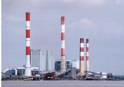
Centrale thermique de Cordemais (Loire-Atlantique) Capacité : 2600 MW
