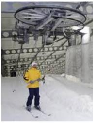
Le site est équipé d'une remontée mécanique de type téléski. Elle permet aux skieurs de remonter la piste à partir de la zone de chargement située en bas de la piste jusqu'à la zone de lâché en haut de la piste. Le téléski est constitué d'un câble tracteur et d'agrès. Le câble tracteur est entraîné par une poulie motrice et parcourt la piste dans sa longueur.
