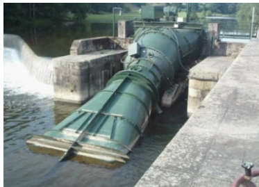
Vue d'un ancien groupe siphon
